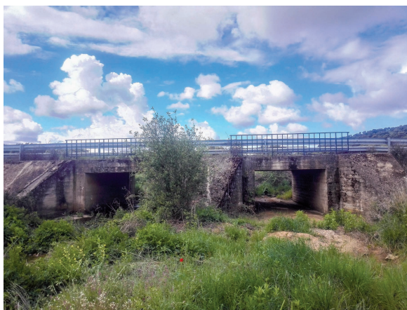
Figura 1. Arroyo de la Rejera en el término municipal de Fuente Obejuna, en el norte de la provincia de Córdoba, donde se encontraron huellas de meloncillo el 1 de mayo de 2018 debajo del puente sobre la carretera CO-7403 que aparece en la foto.
