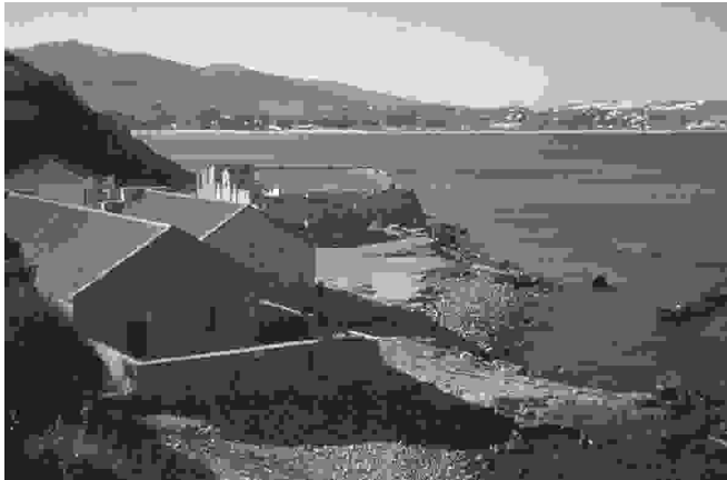
Figura 4. Estas ruinas es todo cuanto queda hoy en día de la antigua factoría ballenera de la Ensenada de Getares (Algeciras), que operó durante la primera mitad del siglo XX en aguas del Estrecho de Gibraltar. (Fotografía de M. Fernández-Casado)
